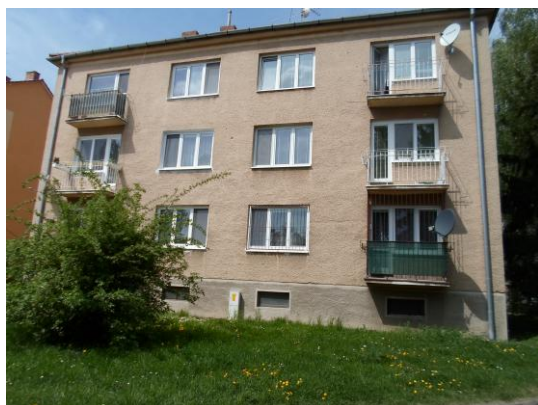
Bytový dom v Piešťanoch
