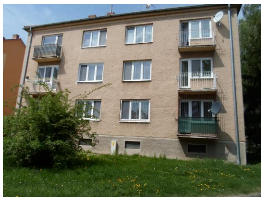
Bytový dom v Piešťanoch
