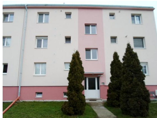
Bytový dom v obci Velké Kostofany
