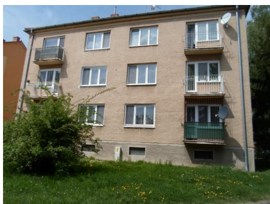
Bytový dom v Piešťanoch
