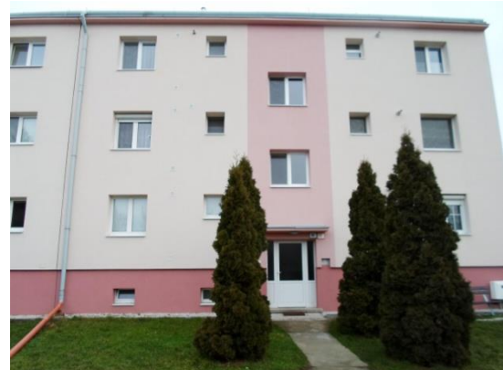
Bytový dom v obci Veľké Kostofany
