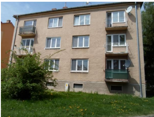
Bytový dom v Piešťanoch
